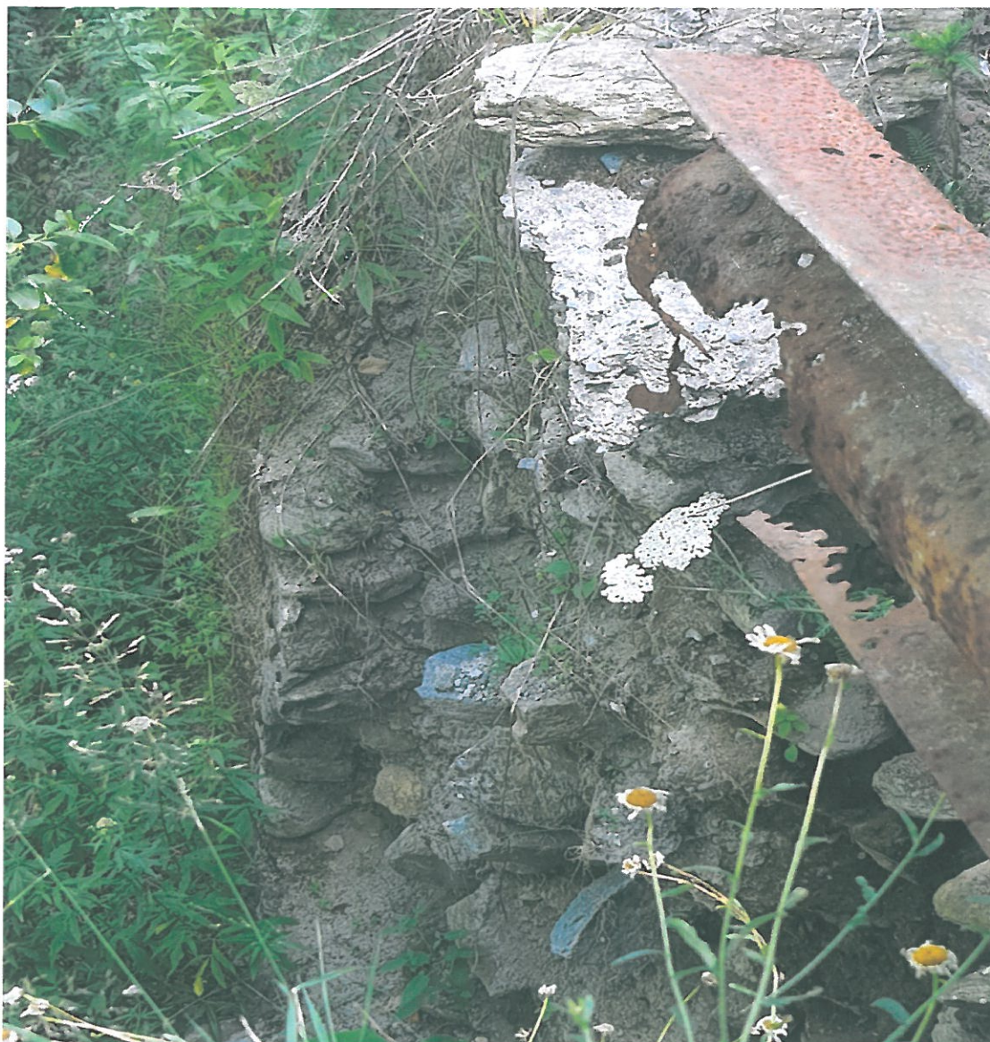
Foto – zid de sprijin rambleu din zidarie de piatra
