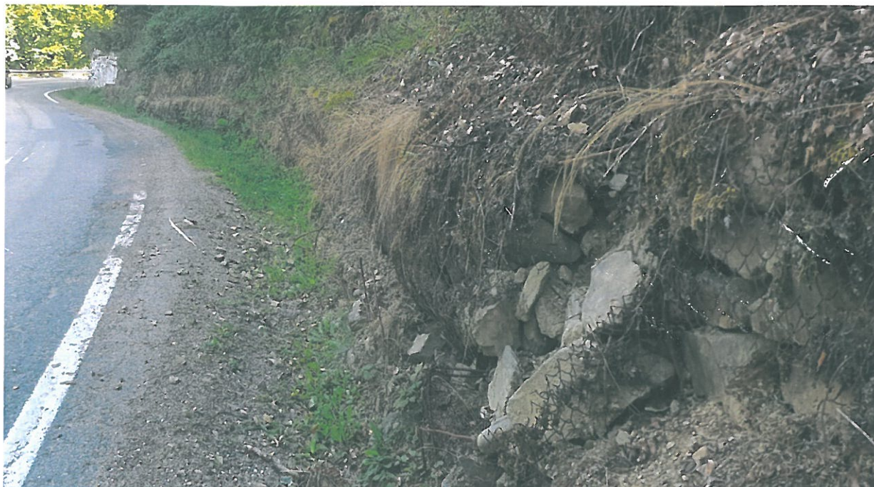
Foto – zid de sprijin debleu din gabioane
