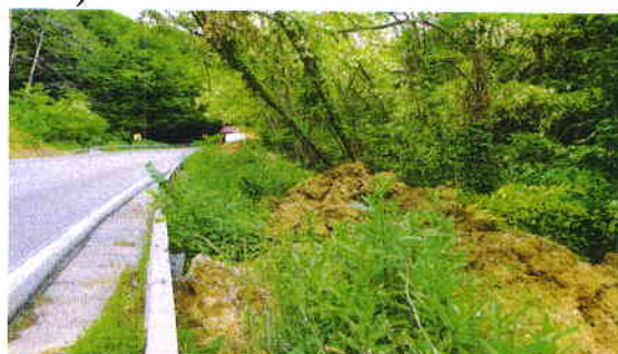
Foto nr. 12: Material excavat depus pe berma taluzului de rambleu. 2017
