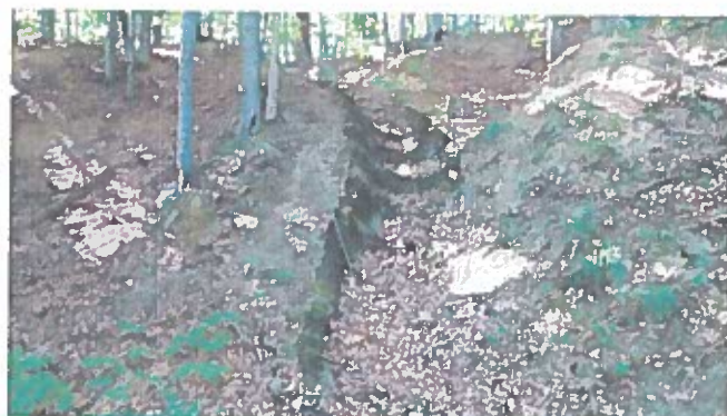
Foto 8 - Sant de garda din beton de ciment, colmatat - zona amonte drum.
