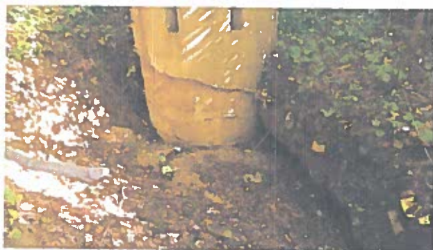
Foto 6 - Vedere camin amonte. Afuierea terenului dintre drum si camin.
