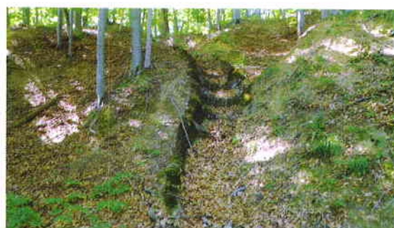
Foto nr. 7: Sant de garda din beton de ciment, colmatat. Zona amonte drum.
