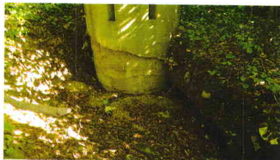
Foto nr. 4: Vedere camin amonte. Sufozia terenului dintre drum si camin. 2017
