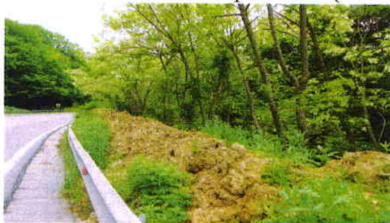
Foto nr. 11: Material excavat depus pe berma taluzului de rambleu. 2019
