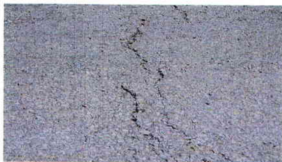
Foto nr. 15: Fisuri transversale pe firul 1 in zona alunecarii.
