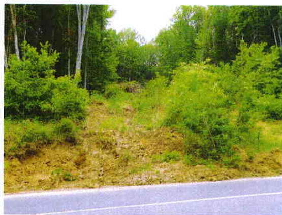
Foto nr 1: Vedere taluz de rambleu alunecat Foto nr. 2: Vedere zona alunecata, la baza de pe firul 1, in 2019 .
