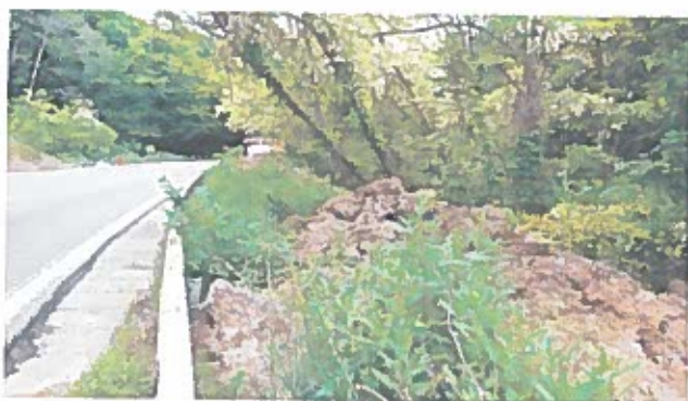
Foto 9 - Material excavat depus pe berma taluzului de rambleu
