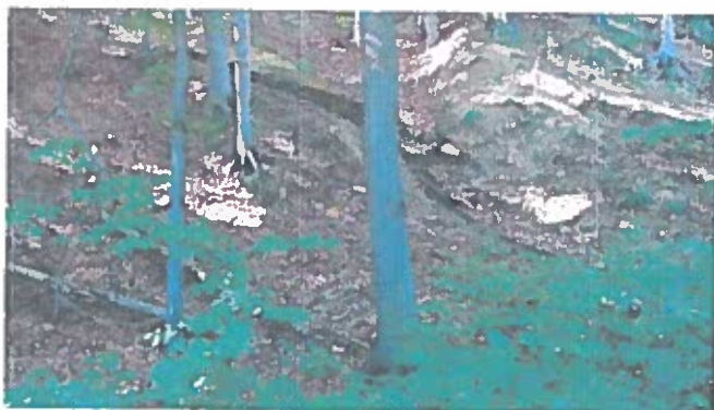
Foto 7 - Sant de garda din beton de ciment colmatat si fara debuseu - zona aval drum
