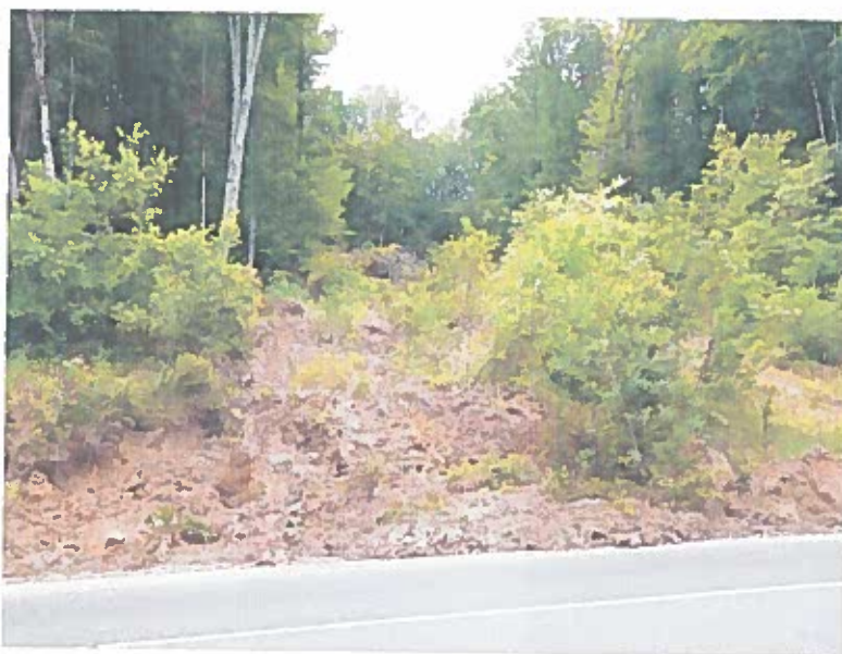
Foto 2 - Zona alunecata - la baza rambleu, de pe firul acostamentului firului 2 – an 2016
