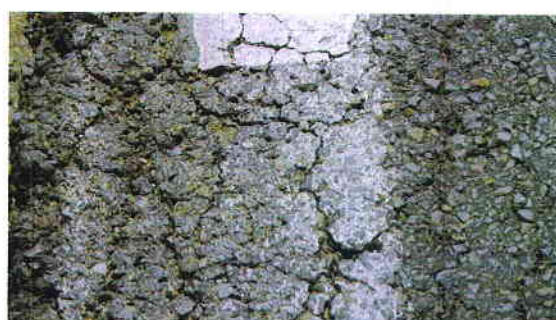
Foto nr. 16: Detaliu degradari imbracaminte intre firul 1 si 2.
